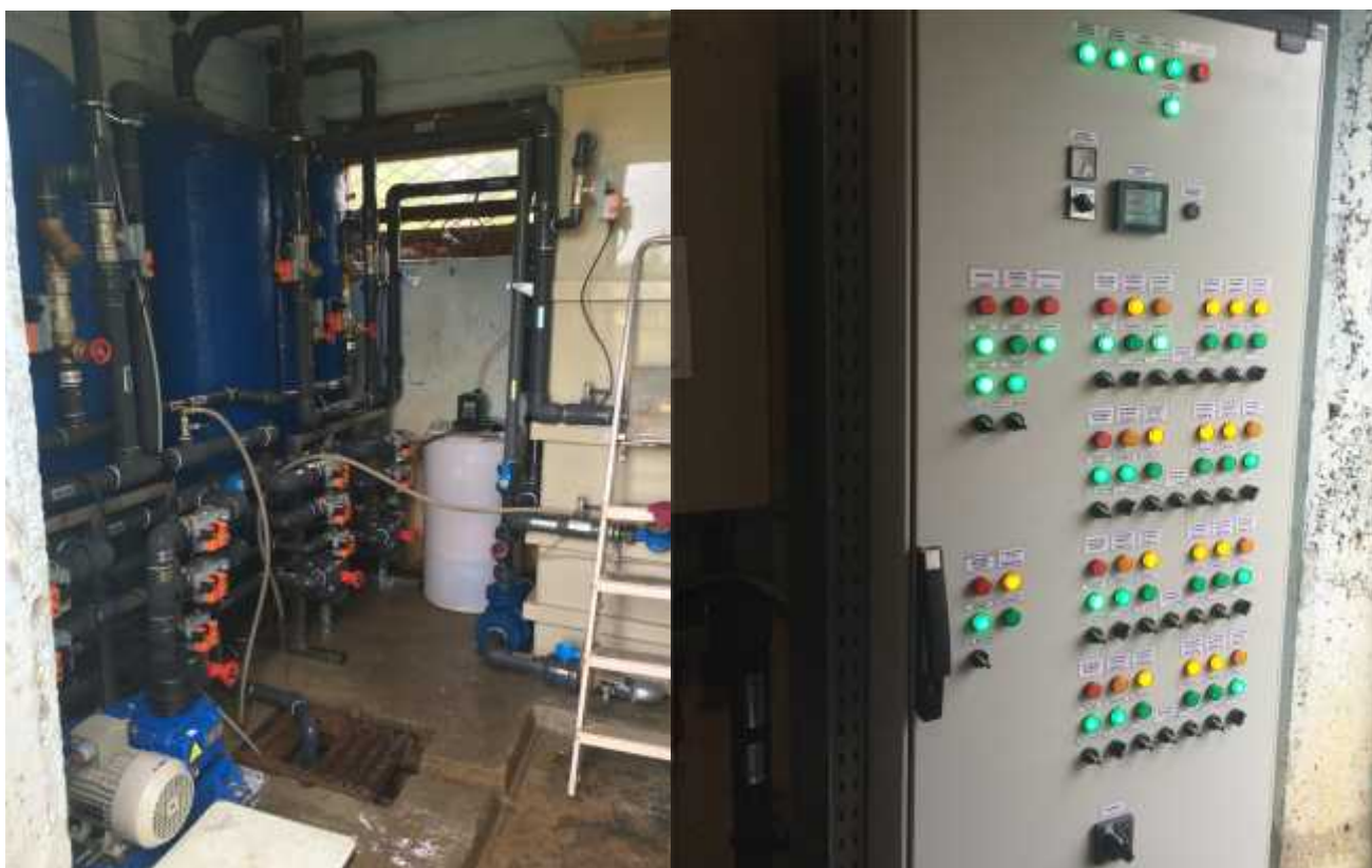
7 pav. Puodžių vandenvietėje įrengti nauji vandens gerinimo įrenginiai
