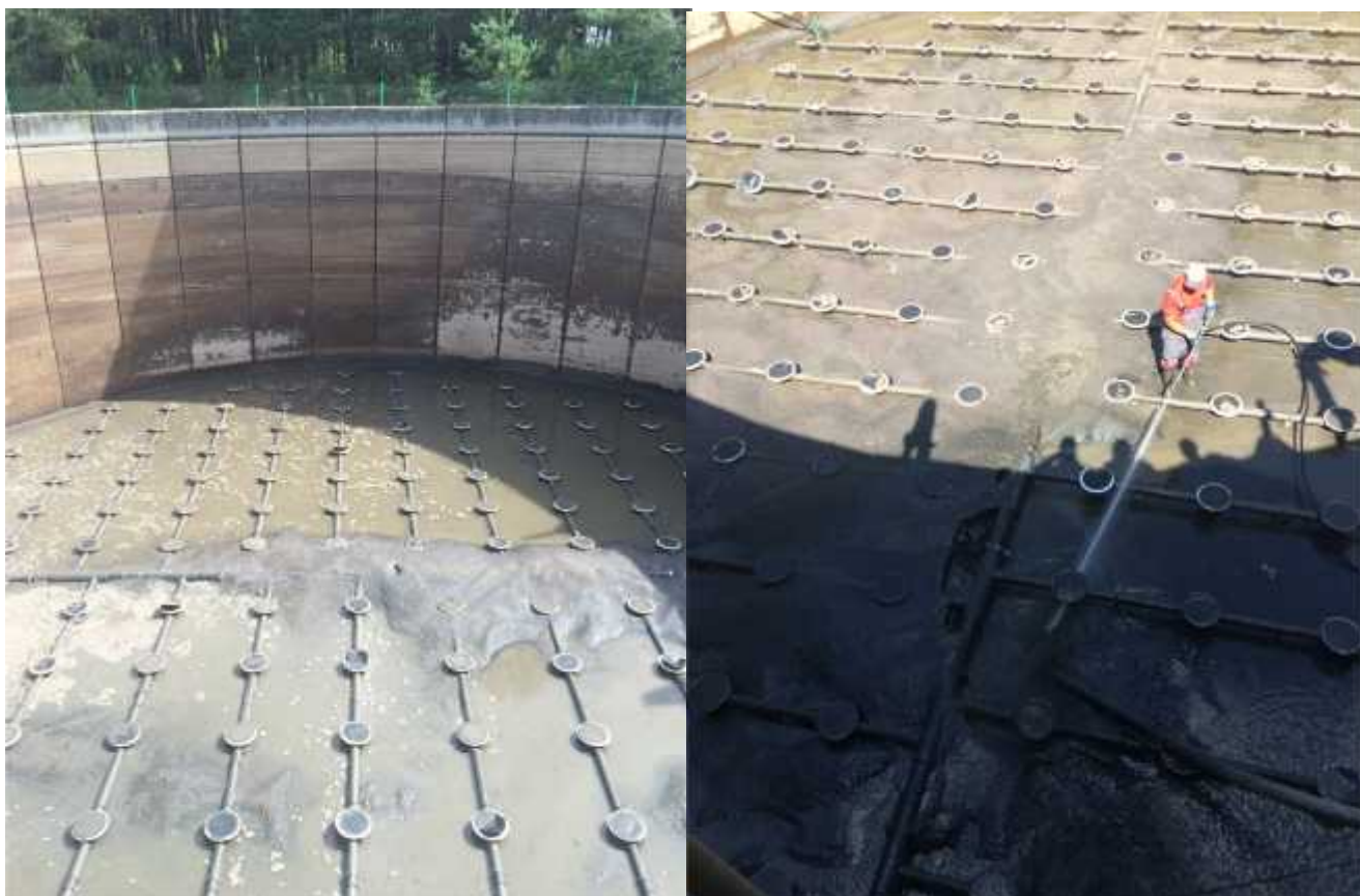
13 pav. Aerotankų tvarkymo-remonto darbai
